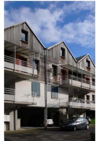
Accès des immeubles escalier /balcon
